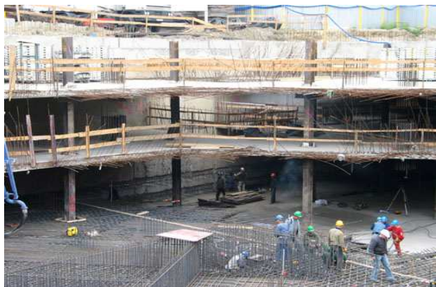
Rys. 1. Zastosowanie metody stropowej przy budowie obiektu biurowo-usługowego w Warszawie (www.geotekst.pl)
