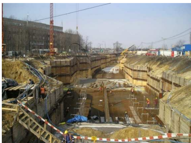
Rys. 2. Budowa Szybki Tramwaj w Krakowie – zastosowanie technologii obudowy berlińskiej (www.fundamenty.com.pl)
